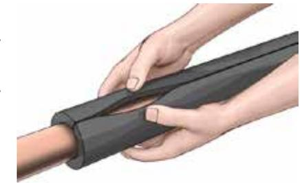
6. Конструкция должна быть смонтирована герметично (все стыки должны быть гарантировано склеены по всей поверхности торцов без видимых просадок и непроклеенных фрагментов клеевого шва).
