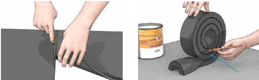
5. Одним движением, без рывков, под углом 30-90° к поверхности теплоизоляции, отрезаем выкройку монтируемого материала.
