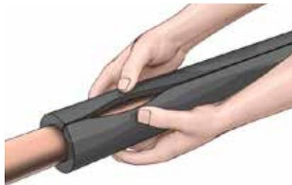
10. Теплоизоляционная конструкция должна быть смонтирована герметично (все стыки должны быть гарантировано склеены по всей поверхности торцов без видимых просадок и непроклеенных фрагментов клеевого шва).
